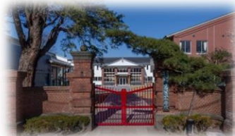
【古河城出城跡に建つ校舎】
